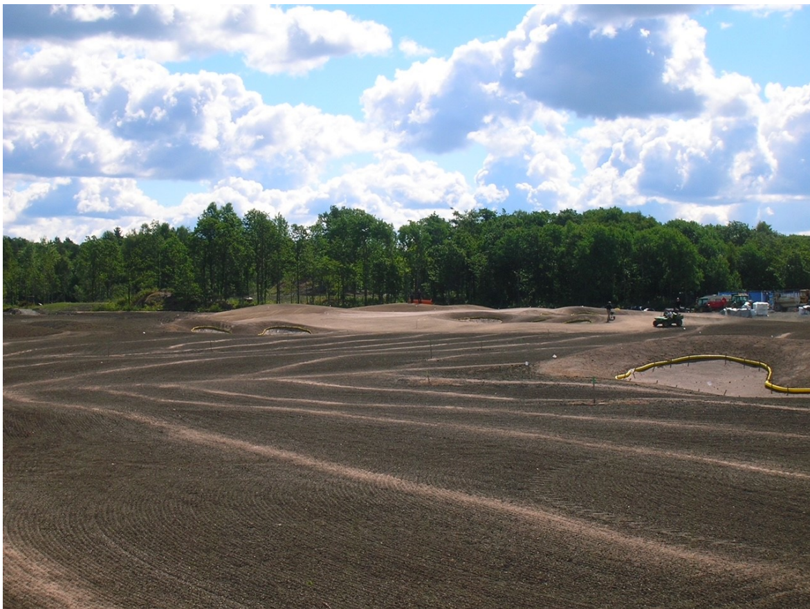
Bilden visar en täckdikad fairway med fungerade ytavrinning (Vallda G&CC). Foto: Stefan Nilsson
