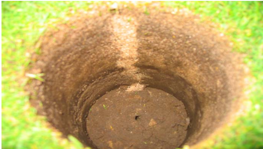
En vertikal sandpelare efter Fill and drill.
